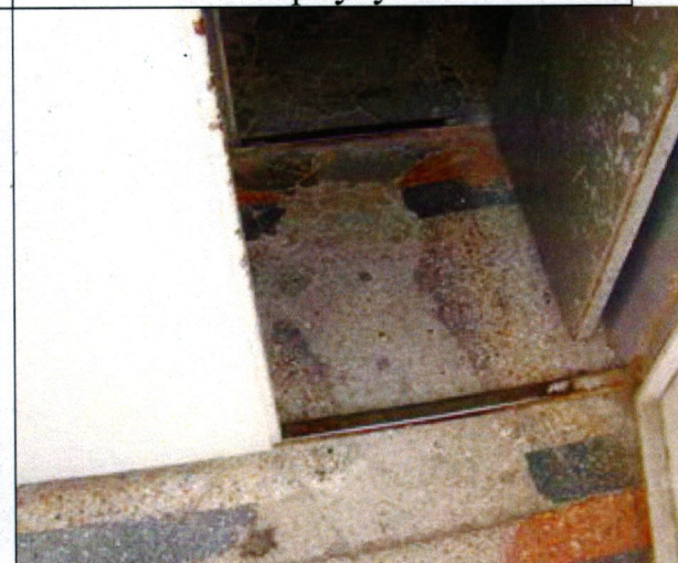
Рис. Б.4. Безперешкодний прохід в фойє корпусу (висота порогів менше ніж 50 мм)
